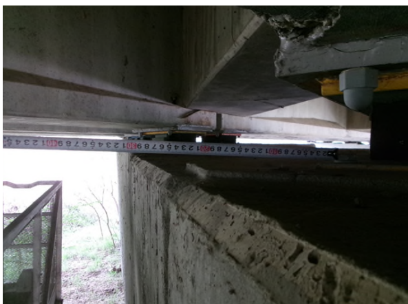
받침장치 연단거리 측정
