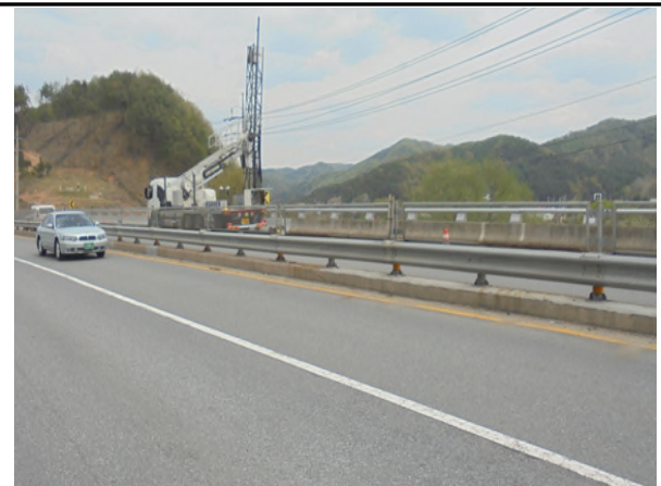
손상현황 • 중분대 전경
